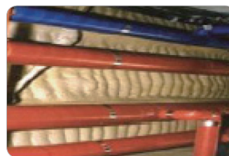
▲ 축사 내 단열재 설치
